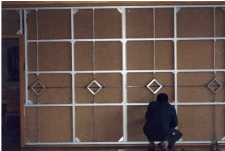
Konstruktion des Schiebetores zwischen Halle und Wirtschaftsraum.
