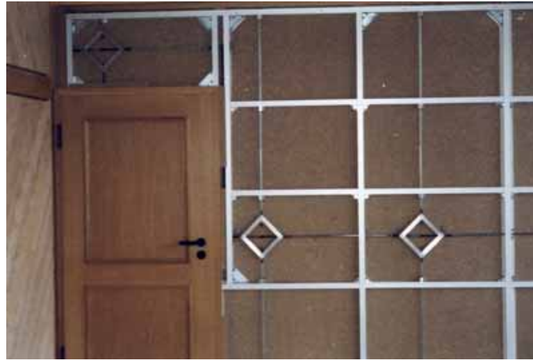
Konstruktion des Schiebetores zwischen Halle und Wirtschaftsraum.
